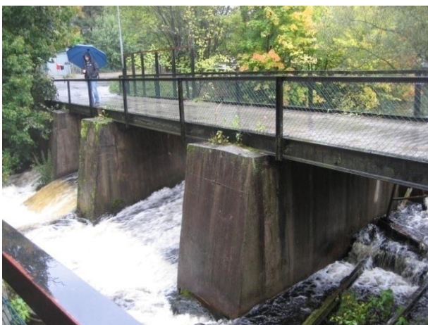
Nedströms dammen sett från vänstra sidan
