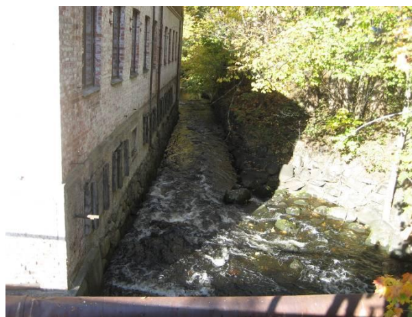
Befintlig å/kanal nedströms de båda högra utskoven
