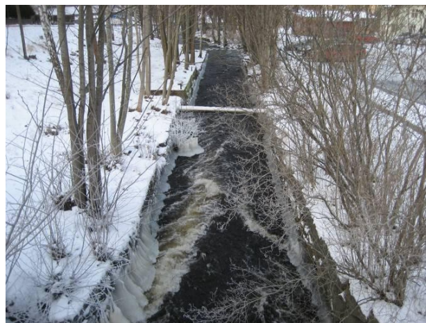
Avloppskanalen vid Pixbovägen.
