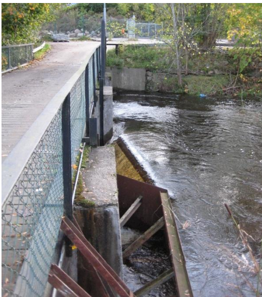
Plåtar framför f.d. kraftverksintaget och utskov nr 3 från höger
